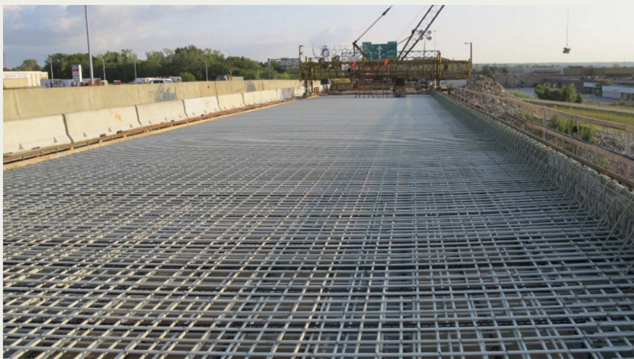
Brodäck armerat med 19 mm GFRP stänger, Kansas City, I-635, USA ( www.aslanfrp.com ).
